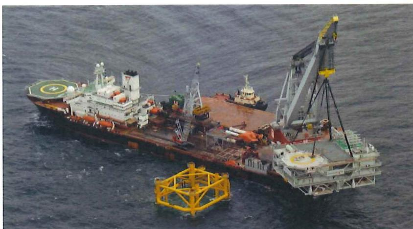
Figure 7 : Installation d'une sous-station (source DONG Energy).
