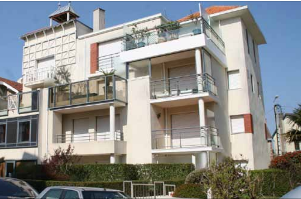
Architecture qui ne s'intègre pas à son environnement balnéaire
