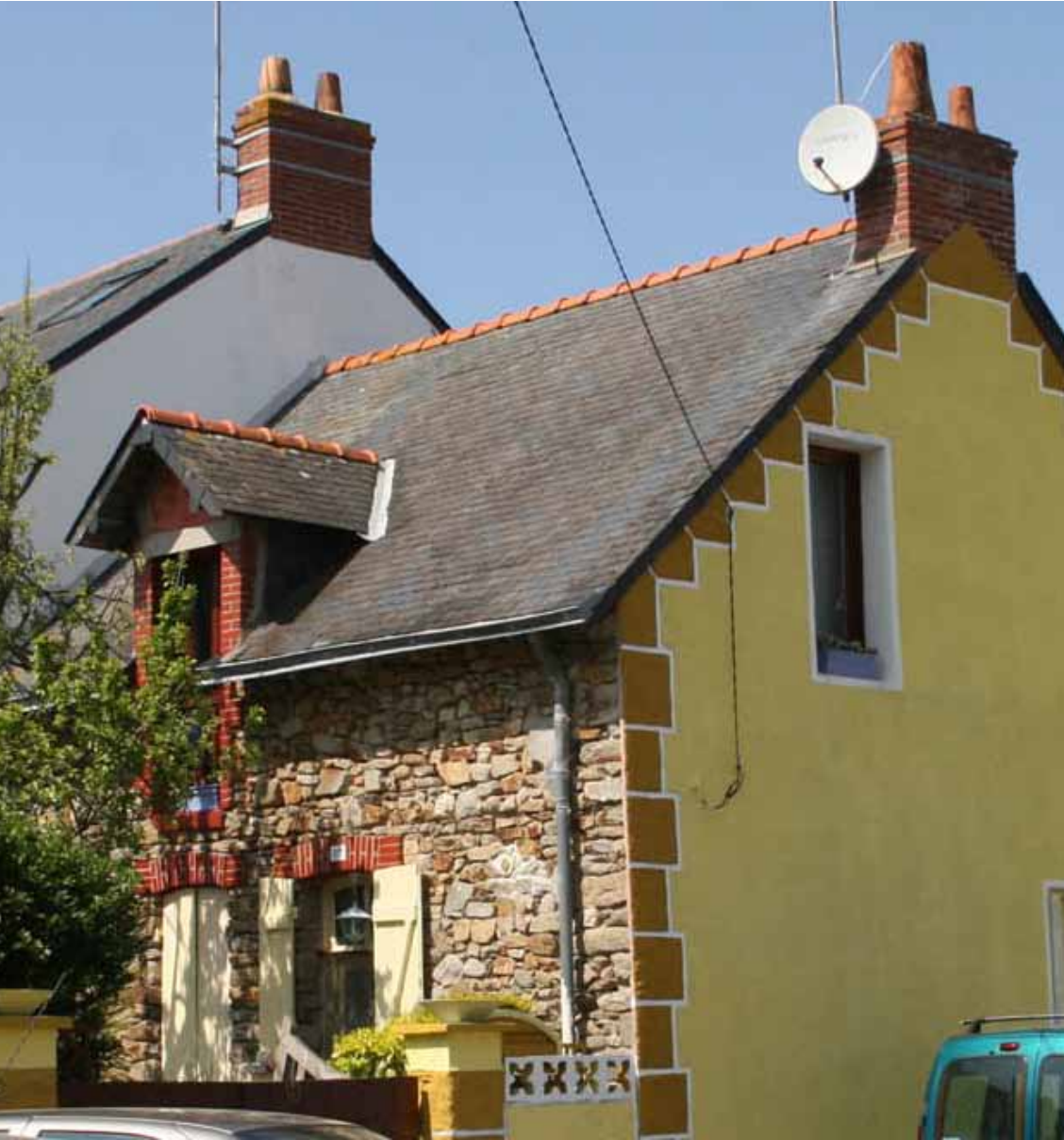
Toitures à brisis
