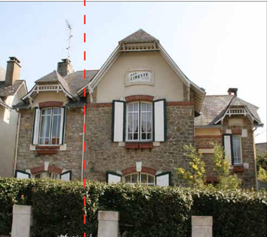
Extension Villa d'origine
