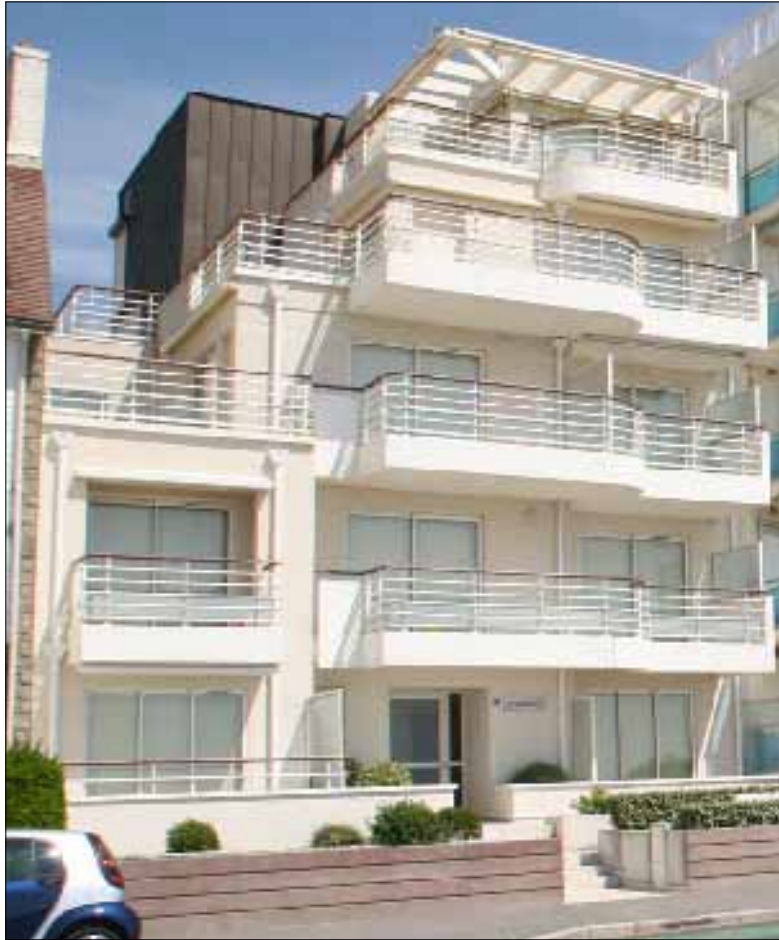
Architecture plus épurée en forme et en couleur
