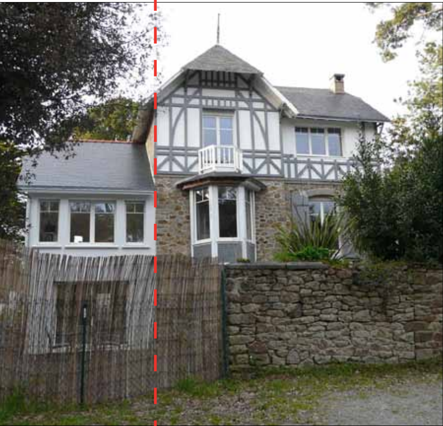
Extension Villa d'origine
