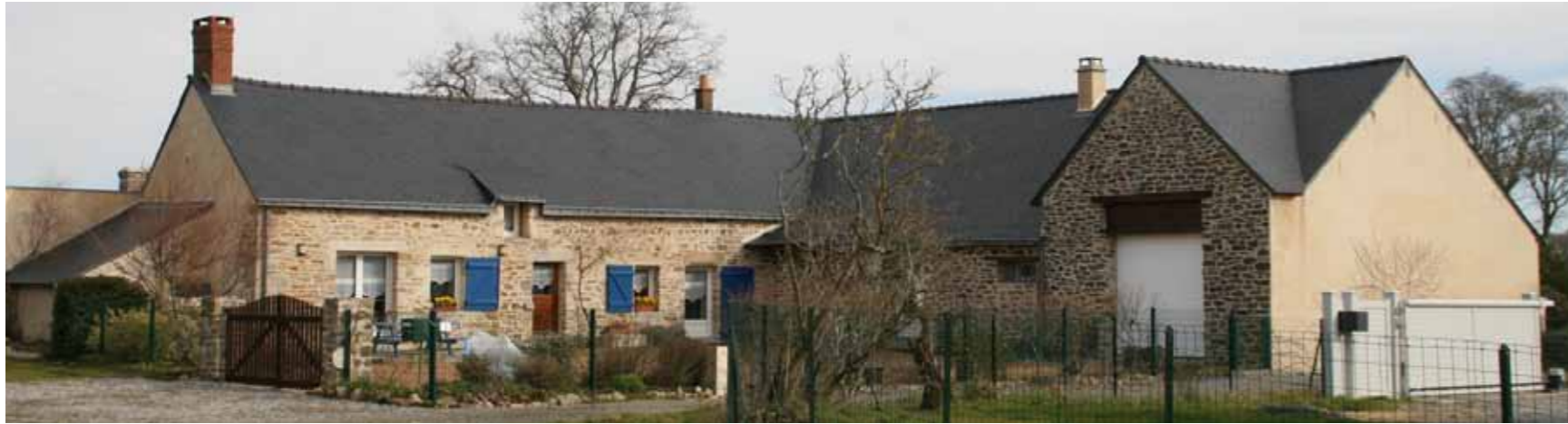
Toitures traditionnelles à deux pans. Avec ou sans lucarnes
