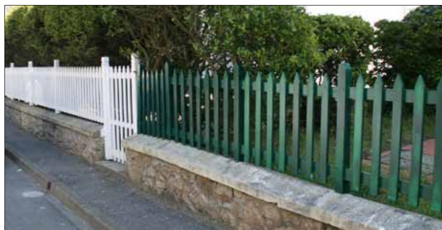
Muret + barrière en bois simple
