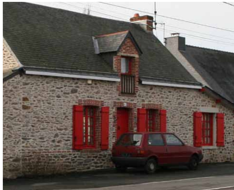
Façades en moellons de pierre apparents.
